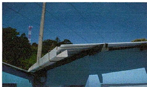
Foto 2: Mejoramiento, entechado lamina troquelada
