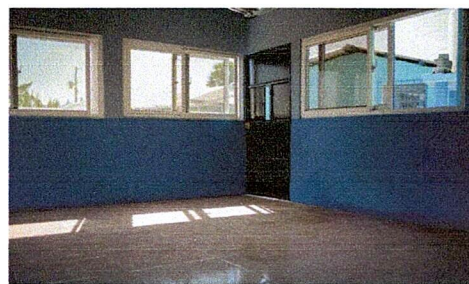
Foto 4: Instalación de puerta para aula.
